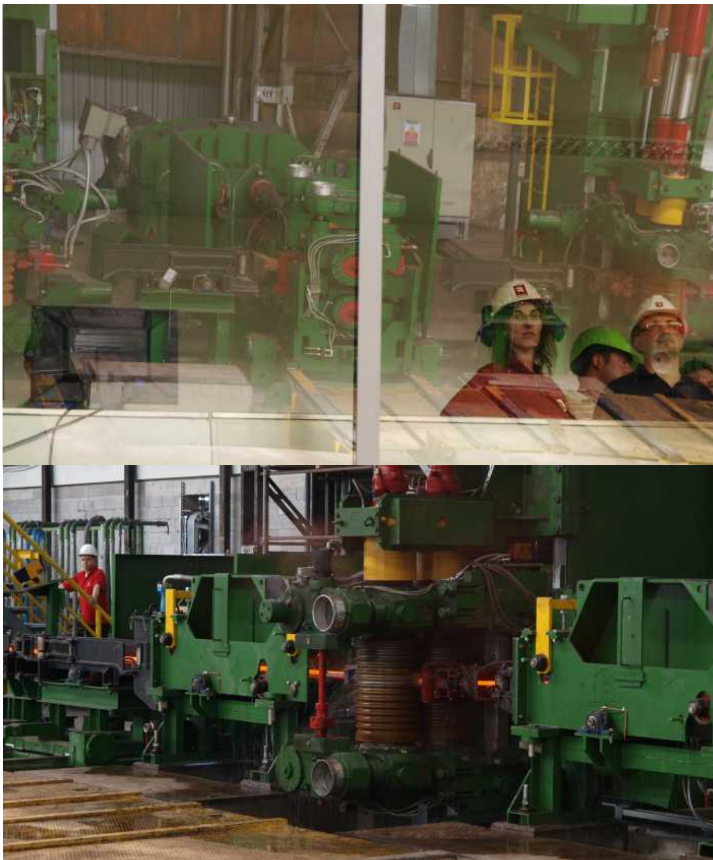
Slika zgoraj: proga v odsevu komandne kabine; slika spodaj: valjanec potuje skozi zadnje ogrodje nove proge
